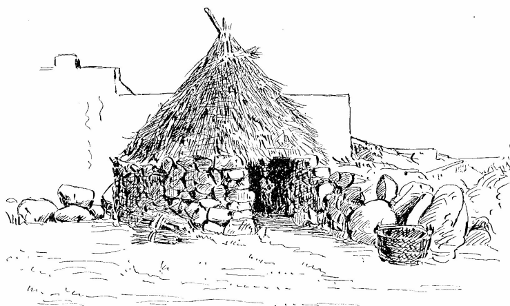
Il paggiaro ('pagghiaru') era realizzato con pietra lavica a secco e tetto di paglia (pagghia) a spiovente. (incisione di Ludovico Salvatore d'Asburgo 1898)
