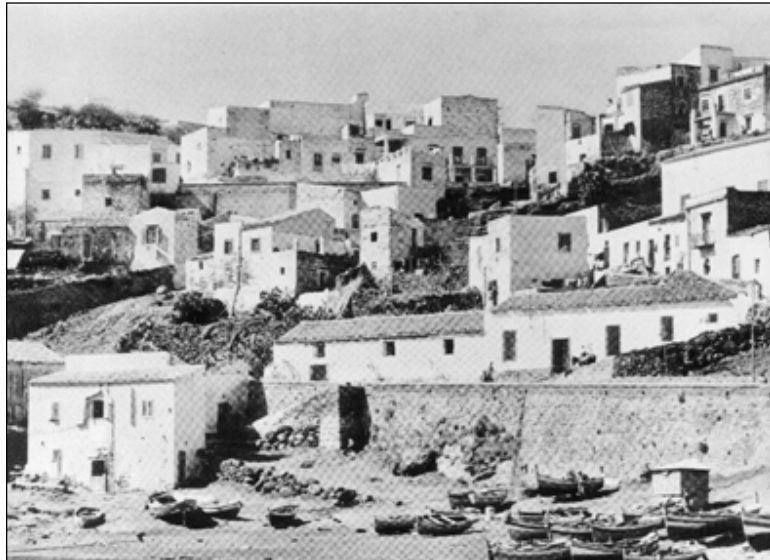
Sopra la spiaggia due grandi cameroni contigui porte e finestre dotate di cancellate e inferriate. Quello di sinistra ancora oggi è nello stato in cui era nel 1911.
