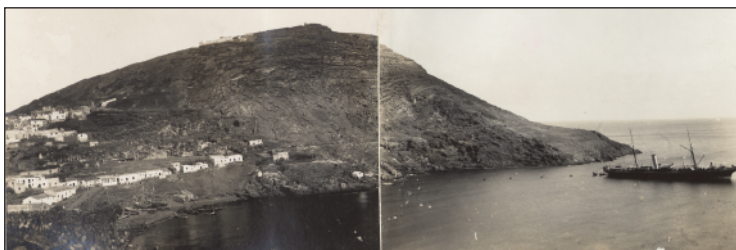
Sopra: La nave posacavi Città di Milano nella Cala S. Maria effettua l'atterraggio del cavo telegrafico.
