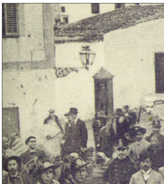
Ustica centro abitato. A sinistra, corpo illuminante a braccio in ghisa alimentato ad olio in uso nel 1911; a destra, corpo illuminante a braccio con piatto in ferro porcellanato bianco, installato dopo il 1933.
