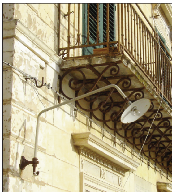
Ustica centro abitato. A sinistra, corpo illuminante a braccio in ghisa alimentato ad olio in uso nel 1911; a destra, corpo illuminante a braccio con piatto in ferro porcellanato bianco, installato dopo il 1933.
