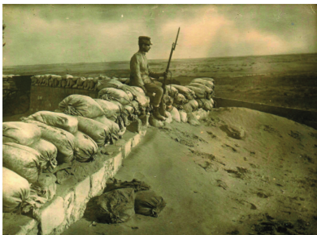
In vedetta nei trinceramenti.
