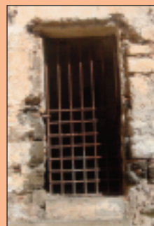
Ingresso di una vecchia cella.
