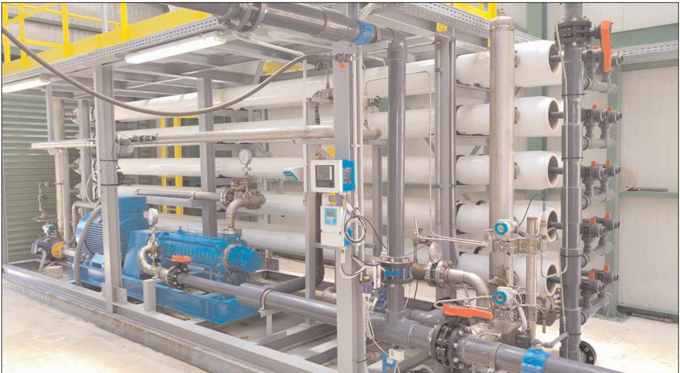
L'impianto a osmosi inversa.
