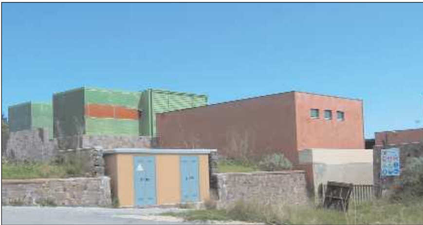
Ustica. Contrada Arso. I due moduli termici nei contenitori verdi ora dismessi a beneficio anche del paesaggio. In primo piano il caseggiato per i moto-generatori.
