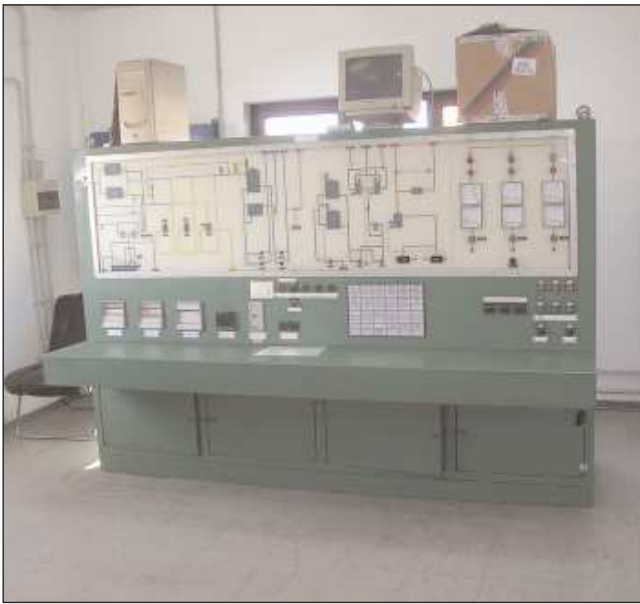
Originario pannello di controllo del dissalatore prima della conversione dell'impianto da MCV a RO.
