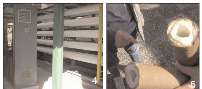
Fig. 1. Schema del procedimento dell'osmosi e dell'osmosi inversa. da www.peteshobbies.com/schema-impianto-osmosi-inversa/ Figg. 2-3. Primi stadi di trattamento dell'acqua. Fig. 4. Terzo stadio di trattamento: batteria di filtri a membrana. Fig. 5. Sezione di un filtro a membrana. Il colore più scuro degli strati esterni è dovuto alla maggiore quantità di "impurità" presenti nell'acqua, e diventa man mano più chiaro. foto A.Valenza
