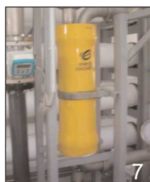
Fig. 6. Impianto di miscelazione. Al permeato viene miscelato ipoclorito di sodio, bicarbonato di sodio, cloruro di calcio e una piccola dose di acqua di mare.
