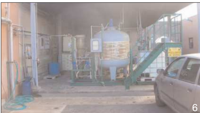
Fig. 6. Impianto di miscelazione. Al permeato viene miscelato ipoclorito di sodio, bicarbonato di sodio, cloruro di calcio e una piccola dose di acqua di mare.
