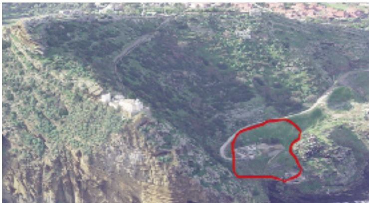
L'interno del cratere della Falconiera, la linea rossa delimita l'area del Villaggio preistorico Omo Morto ; al suo interno le strutture del depuratore.
