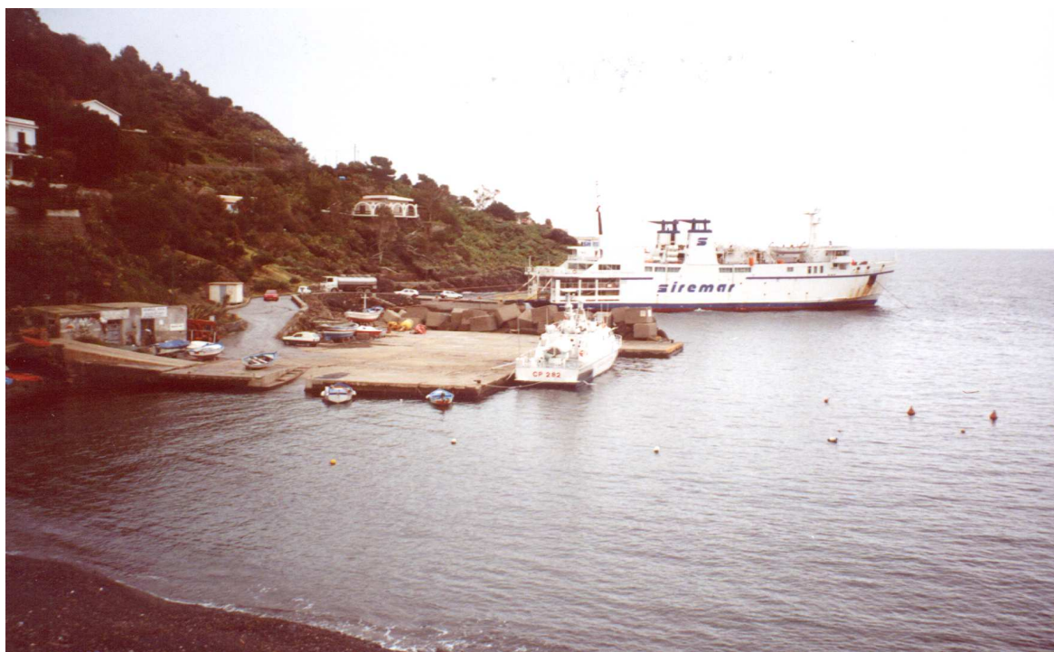
La nave Antonello da Messina attraccata nella Cala S. Maria. La banchina Barresi (in primo piano) è stata prima messa a nudo sino alle fondazioni e poi allagata.
