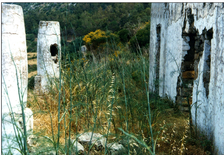
Il terrazzo prima e dopo le opere di restauro. Si notino le colonne stile eoliano e l'incavo in esse ricavato per riporvi il lume e le lucerne al riparo dal vento.
