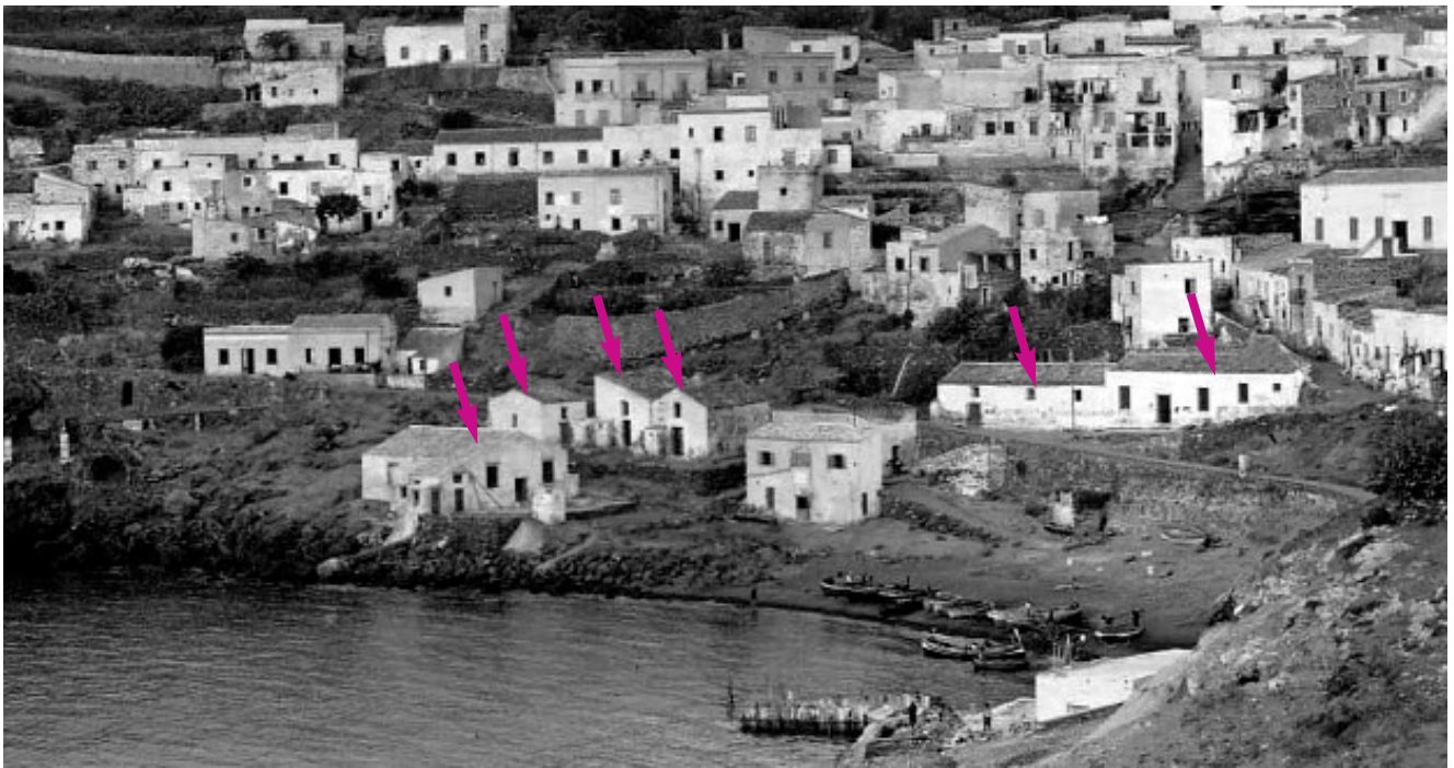
I cameroni della Marina segnalati dalle frecce.
