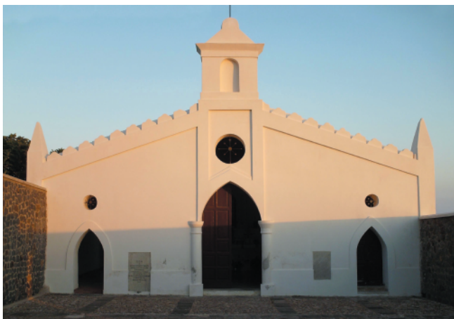
Il prospetto interno nel cimitero dell'isola.
